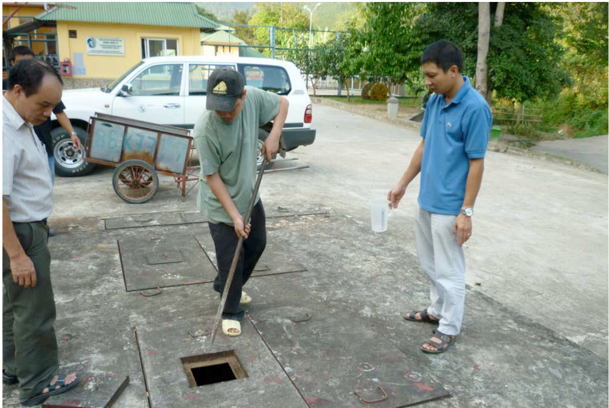
Bild 3: Besuch einer DEWATS Anlage in einer Bear Rescue Farm
