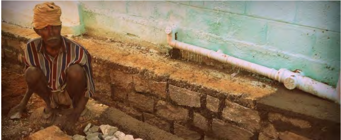
Figure 1: Instandhaltungsarbeiten an einer Abwasserleitung
